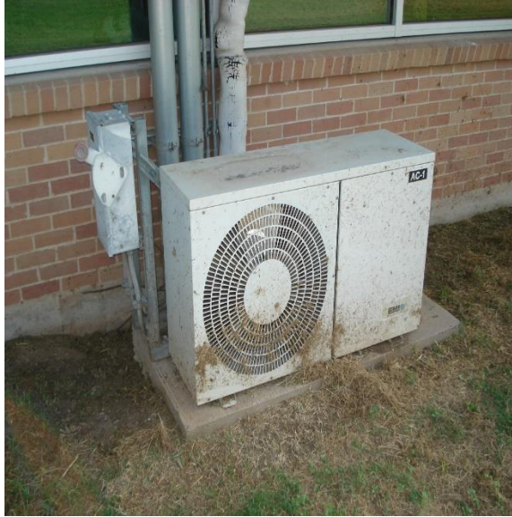
Figure 3 – Mini Split Condensing Unit
