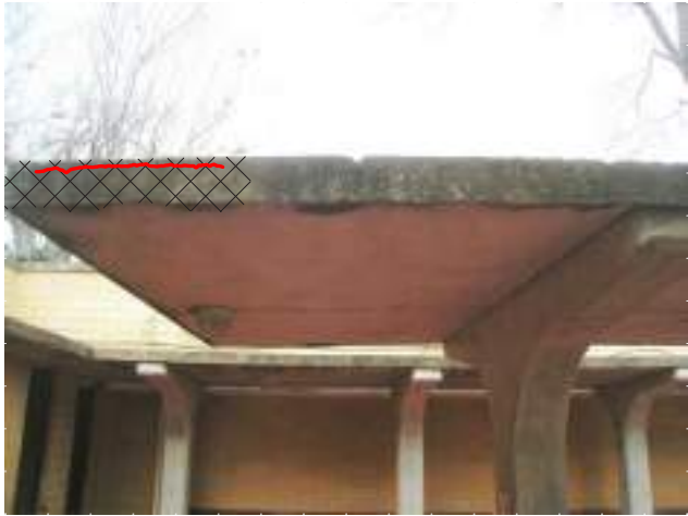
D SLAB EDGE REPAIR x/x' = 1'-0"
