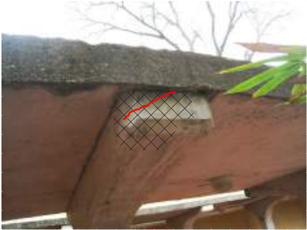
C BEAM EDGE REPAIR x/x' = 1'-0"
