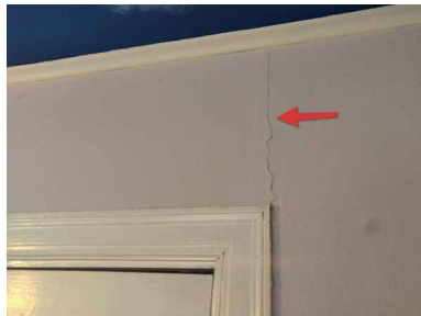
Left side hallway - drywall crack.
